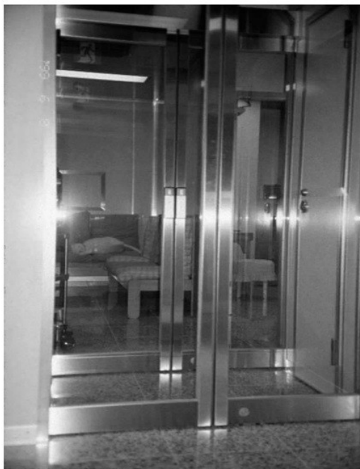
FIGUUR 5.6 Ingang van een 'Clean Room' voor CS patiënten met positieve luchtdrukregeling om het binnendringen van chemische verontreiniging van buitenaf te voorkomen. De ruimte is ook afgeschermd tegen elektromagnetische golven.
