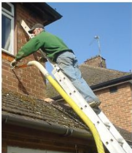
Fig.21.5: (links) Spouwmuurisolatie in uitvoering
