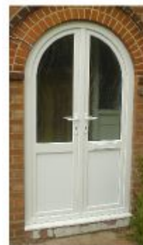
Fig.21.6: (rechts) Een nieuwe toegangsdeur
