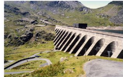
Afb.26.6: Llyn Stawlan, het bovenste reservoir van het Ffestiniog pompaccumulatieproject in Noord-Wales. Opgeslagen energie: 1,3 GWh. Foto door Adrian Pingstone
