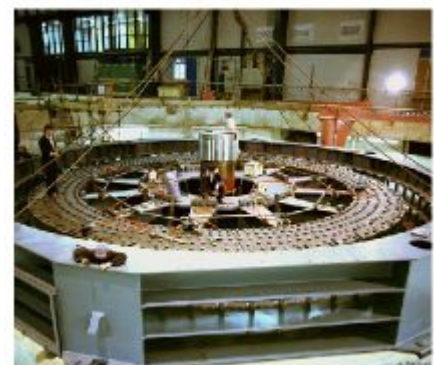
Fig.26.15: een van de twee vliegwiel op de Culham fusie-onderzoekslocatie, in aanbouw. Foto EFDA-JET. www-jet.efda.org
