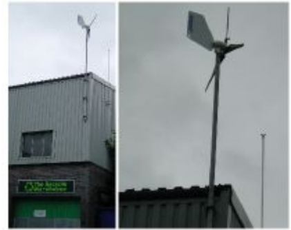
Fig.B.9: Een Ampair "600W" microturbine. Het gemiddelde vermogen dat door deze microturbine in Lemington Spa wordt opgewekt, bedraagt 0,037 kWh per dag (1,5 W).
