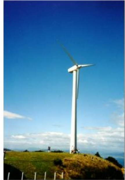
Afb.B.3: De Brooklyn windmolen bij Wellington, Nieuw Zeeland, met mensen ter vergelijking op schaal. Op een winderige dag genereerde deze windmolen 60 kW (1400 kWh/d). Foto door Philip Banks
