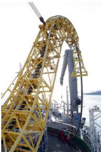
Fig.25.7: Het leggen van een HVDC-kabel tussen Finland en Estland. Een dergelijk kabelpaar kan 350 MW aan vermogen overbrengen. Foto: ABB
