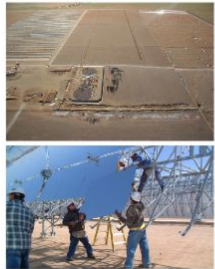
Fig.25.4: Andasol, Spanje - een "100MW" zonne-energiecentrale in aanbouw. De resterende thermische energie die overdag wordt geproduceerd, wordt tot zeven uur lang opgeslagen in tanks met vloeibaar zout, waardoor een continue en stabiele elektriciteitsvoorziening wordt gegarandeerd. De centrale zal naar verwachting 350 GWh per jaar leveren (40 MW). De parabolische troggen beslaan 400 hectare, zodat de vermogensdichtheid per landoppervlakte 10 W/m 2 bedraagt. Foto boven: ABB, foto onder: IEA SolarPACES.
