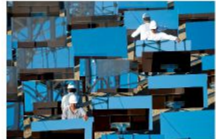
Afb.25.12: Twee ingenieurs zetten een eSolar-centrale op met heliostaten (spiegels die kunnen draaien en kantelen om de zon te volgen). esolar-com maakt middelgrote energiecentrales: een 33MW(piek)-centrale op 64 hectare. Dat is 51 W/m 2 (piek), op een typische woestijnlocatie schat ik dat ongeveer 25% daarvan als continu vermogen kan worden geleverd: 13 W/m 2 .
