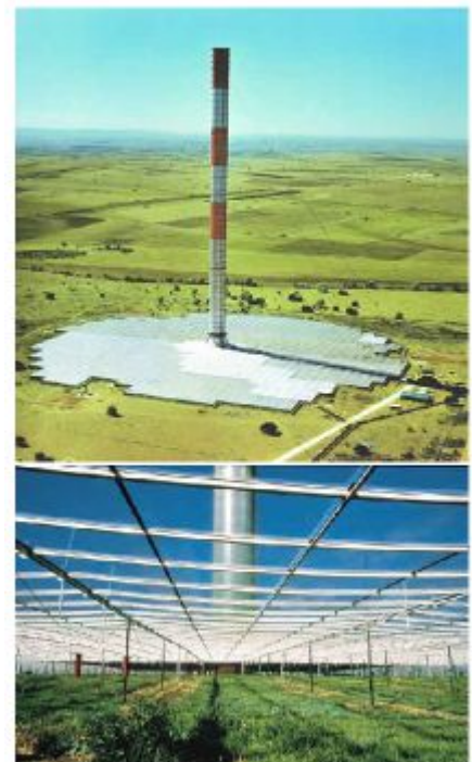
Fig.25.10: Het prototype van de thermische centrale in Manzanares. Foto's van solarmillennium.de
