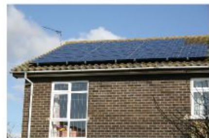
Fig.6.5: Fotovoltaïsche energie: gegevens van een 25 m 2 grote module-opstelling in Cambridgeshire in 2006. De piekopbrengst van deze opstelling is ongeveer 4 kW. Het gemiddelde over het jaar is 12 kWh per dag. Dit is 20 W per vierkante meter moduleoppervlak.
