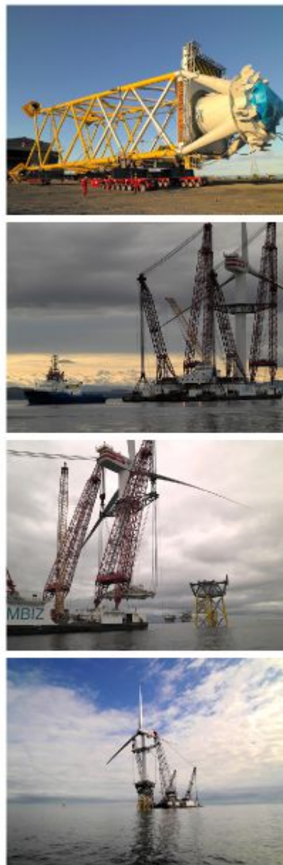
Fig.10.8: Bouw van het Beatrice Demonstratie Offshore Windmolenpark in diep water. Foto met dank aan Talisman Energy (UK) Limited.
