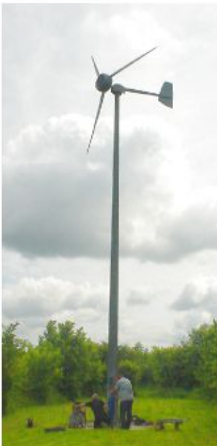
Fig.B.10: Een Iskra 5 kW turbine [www-iskra-wind.com] met een diameter van 5,5 m die jaarlijks onderhoud ondergaat. Deze turbine staat in Hertfordshire (niet een van de winderigste plaatsen in Engeland) op een hoogte van 12 m en heeft een gemiddeld vermogen van 11 kWh per dag. Een windmolenpark met machines van dit vermogen, elk op 30 m x 30 m, zou een energiedichtheid per oppervlakte-eenheid van 0,5 W/m 2 hebben.
