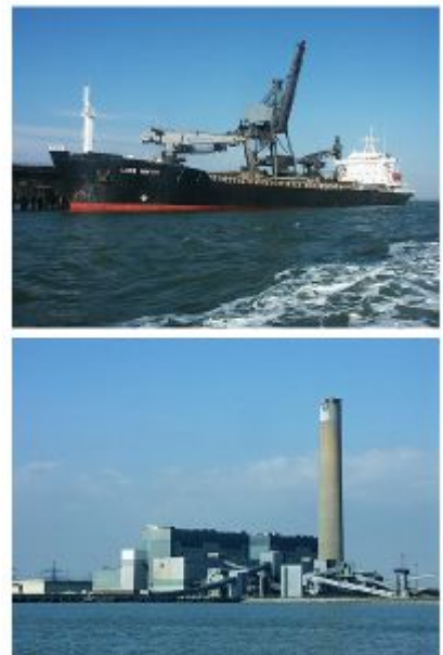
Afb.23.1: Kolenvoorziening voor Kingsnorth Power Station (vermogen 1940 MW) in 2005. foto door Ian Boyle www-simplonpc.co.uk
