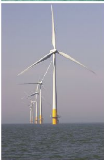
Fig.10.1: (links) Kentish Flats - een off-shore windmolenpark in ondiep water. Elke rotor heeft een diameter van 90 m, de ashoogte is 70 m. Elke "3 MW"-turbine weegt 500 ton, waarvan de helft de fundering is. Foto met dank aan © Elsam (elsam.com.)
