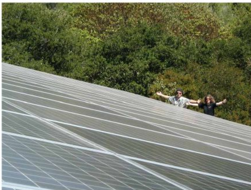
Afb.6.6: twee zonnekrijgers genieten van hun PV-systeem, dat hun elektrische auto's en hun huis van stroom voorziet. Het array van 120 modules (elk 300 W of 2,2 \text{ m}^2 ) heeft een totale oppervlakte van 268 \text{ m}^2 , een piekvermogen (vóór omvormerverliezen) van 30,5 kW, en een gemiddeld vermogen - in Californië in de buurt van Santa Cruz - van 5 kW ( 19 \text{ W/m}^2 ). Foto met dank aan Kenneth Adelman www-solarwarrior.com
