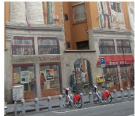
Fig.20.15: Een Vélu'v-station in Lyon
