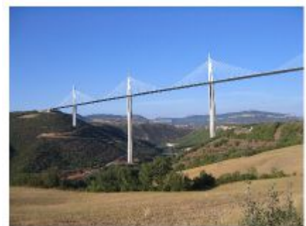
Fig.H.7 : Het viaduct van Millau in Frankrijk, de hoogste brug ter wereld. Staal en beton, 2,5 km lang en 353 m hoog.
